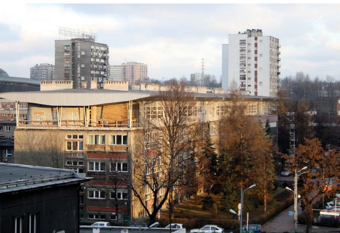
Budynek rektoratu Uniwersytetu Śląskiego w Katowicach, ul. Bankowa 12
