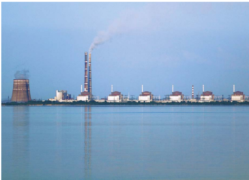
Zaporoska Elektrownia Jądrowa w Enerhodarze | fot. Ralf1969, Wikipedia
